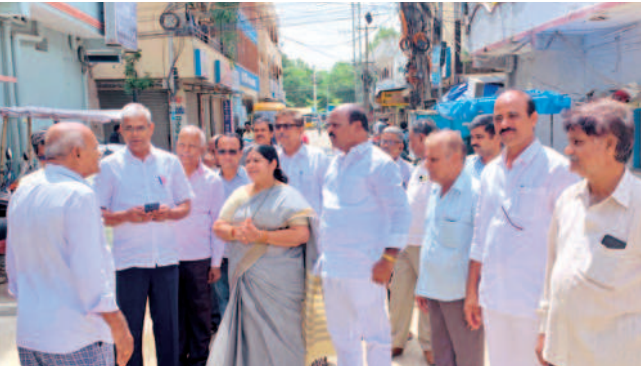
రోడ్డు నిర్మాణ పనులను పరిశీలిస్తున్న కార్పొరేటర్ పుష్పనగేష్
